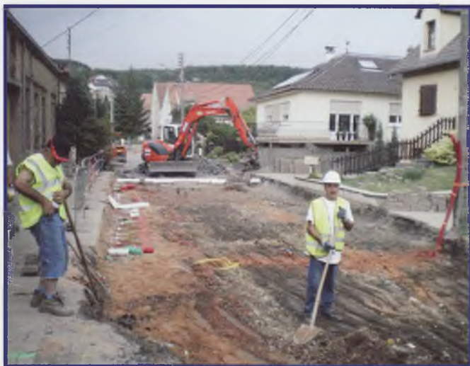
Les travaux de la rue Bellevue
