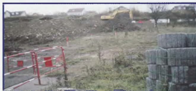
La jonction rue du bassin, Lotissement à l'orée du bois par l'entreprise Eurovia.
