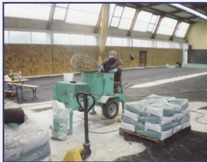
La pose d'un revêtement caoutchouc dans la salle polyvalente par l'entreprise Guinamic Sols Coulés de Singrist (Bas-Rhin)
