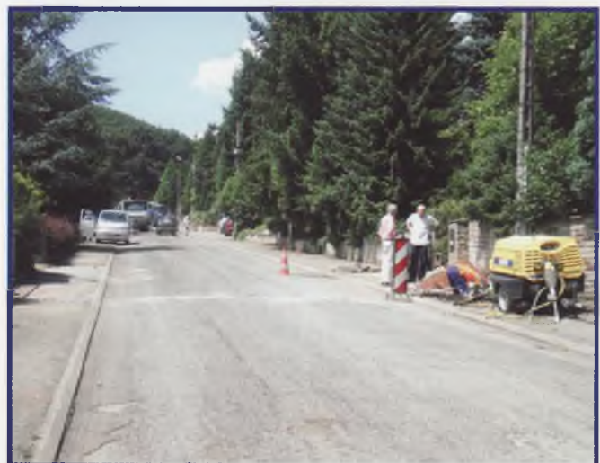
La réfection de la rue de Simbach et de la rue de la frontière avec fraisage et pose d'une nouvelle bande de roulement, ainsi que le remplacement des chicanes par un ralentisseur par élévation de la chaussée.
