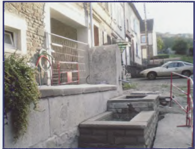
La rénovation de la fontaine située devant la grotte, et la fontaine de la rue de la fontaine, grâce à une équipe de volontaires
