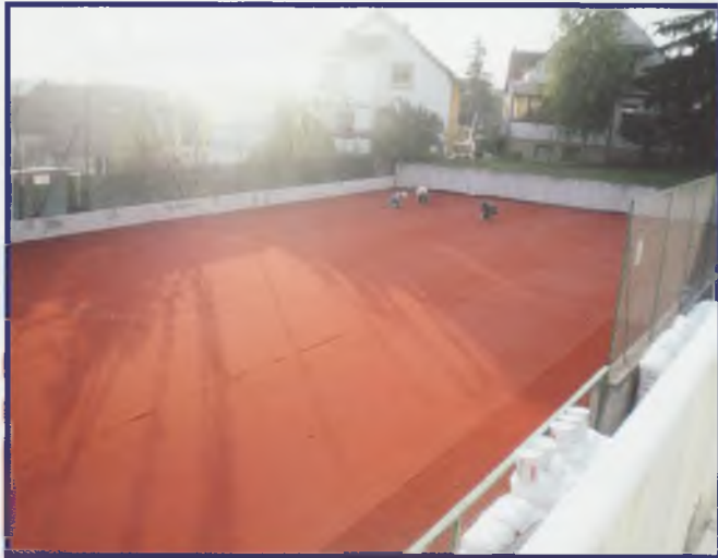
La réfection du court N°2 du terrain de tennis ainsi que le mur de soutènement
