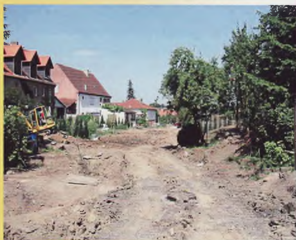
Travaux Rue de Simbach
